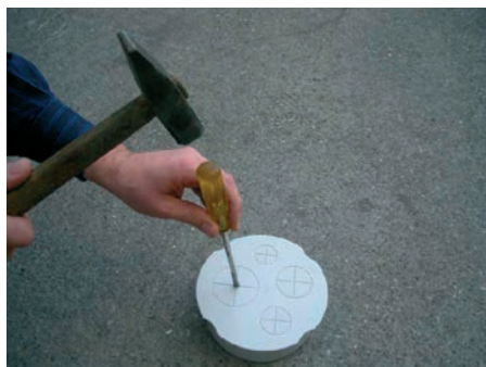
2. В монтажном элементе подготовить отверстия нужного диаметра
