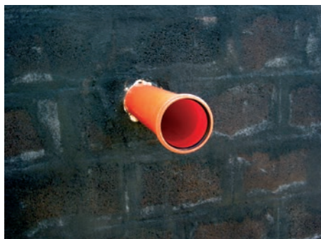
1. Труба проведена через стену с битумным покрытием.
