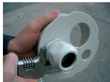
3. Установить и зафиксировать кабельные вводы.
